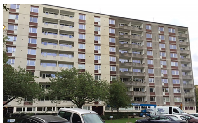
Vänstra delen av byggnaden är tvättad och behandlad med Disboxan 451 Impregneringscreme medan den till höger är obehandlad.
